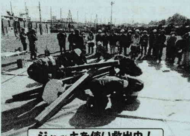
ジャッキを使い救出中！
